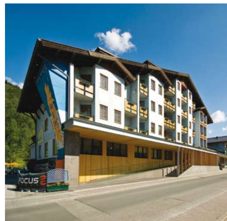
Neue Erdgeschoßzone als markanter Kontrast zum Bestand beim Hotel Tauernhof in Flachau von LP Architektur. Foto: Atelier Wolf / Susanne Reisenberger-Wolf
